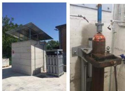
*Struttura speciale in cemento armato <bunker> per la rimozione in sicurezza delle valvole danneggiate*
